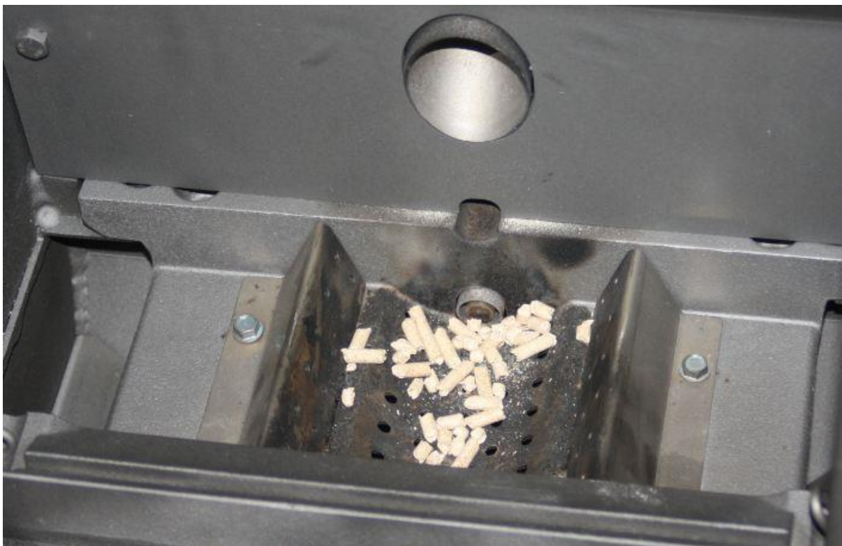
Ovan: Del av eldstaden där förbränningen sker. Bakom "brännkoppen" skymtar tändelementet.
