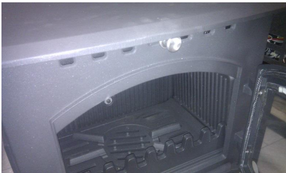
Ovan t.v: Eldstaden sedd uppifrån. Uptill syns reglage för sekundärluft.
